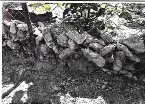
Foto 1: REPARACIÓN DEL MURO PERIMENTRAL
