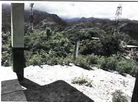
Foto 3: REPARACIÓN DE PLANCHA DE CONCRETO DEL PATIO
