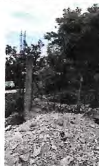
Foto 2: REPARACIÓN DEL MURO CON BLOC Y TUBO CARBANIZADO
