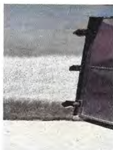
Foto 3: Sustrucción de puerta, y sustrucción de balcones
