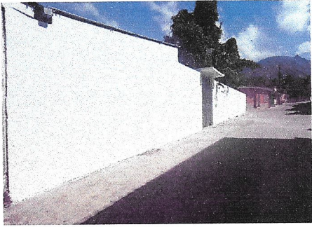
Foto 2: MURO PERIMETRAL EN CALLE PRINCIPAL
