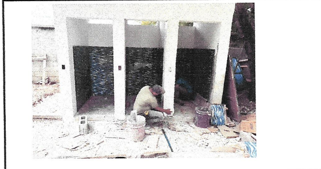
Foto 4: VISTA DE FRENTE DE LOS SERVICIOS SANITARIOS
