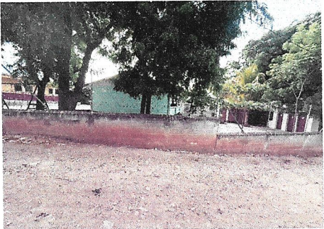
Foto 3: MURO PERIMETRAL EN CARRRETERA QUE CONDUCE HACIA ALDEA SAN ANTONIO
