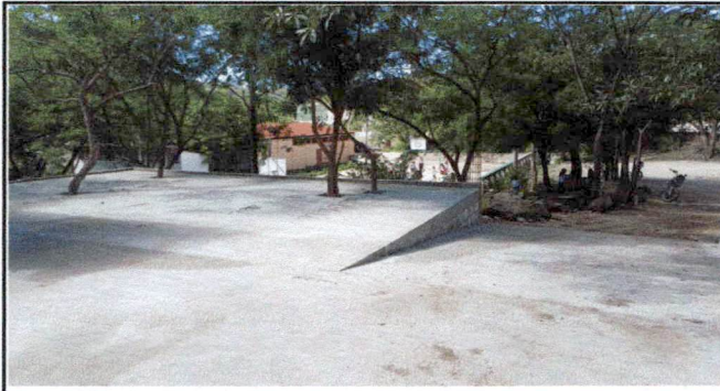
Foto 8: Reparación de planchas de concreto de patio
