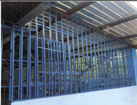
Foto 7: Mantenimientos de barandas de metal
