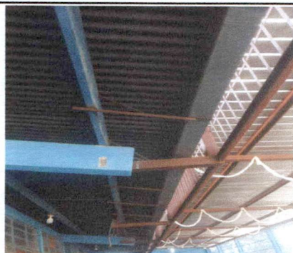
Foto 3: Sustitución de canal de metal
