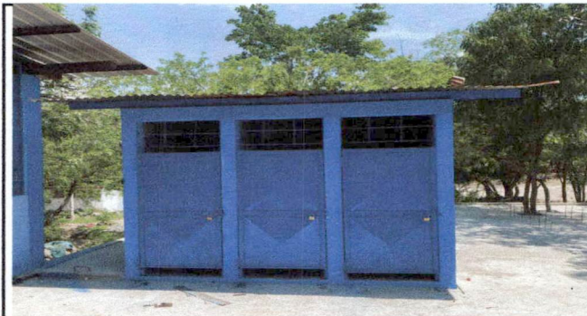
Foto 6: Sustitución de puertas de sanitario
