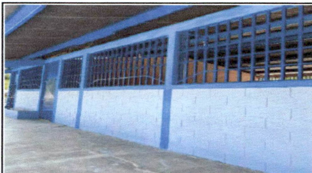
Foto 4: Pintura de muros externos e internos
