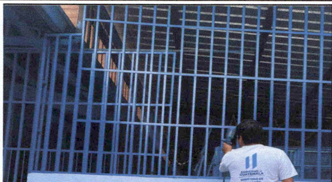
Foto 7: Mantenimientos de barandas de metal
