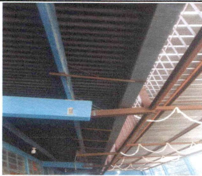
Foto 3: Sustitución de canal de metal
