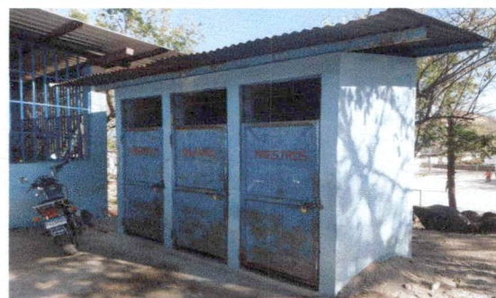
Foto 6: Sustitución de puertas de sanitario
