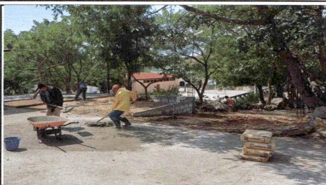
Foto 8: Reparación de planchas de concreto de patio
