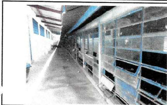
Foto 1: Sstitución de ventanas por balcones
