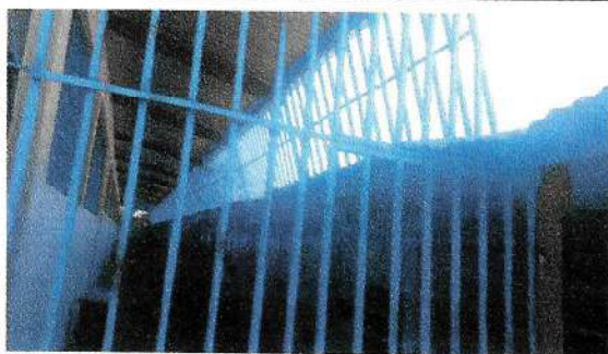
Foto 7: Mantenimientos de barandas de metal
