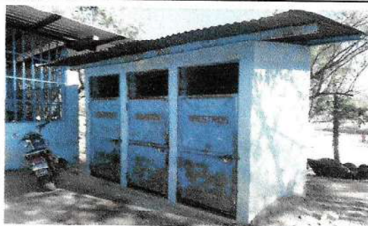
Foto 6: Sustitución de puertas de sanitario
