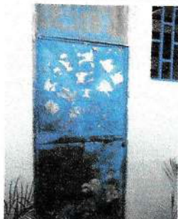
Foto 5: Mantenimiento, estructura de puertas
