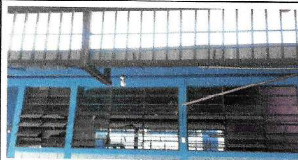
Foto 2: Mantenimiento de estructura de soporte de metal
