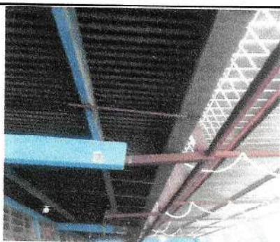
Foto 3: Sustitución de canal de metal
