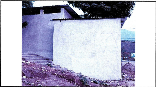
Foto7: REPARACIÓN DE MURO PERIMETRAL DE BLOCK
