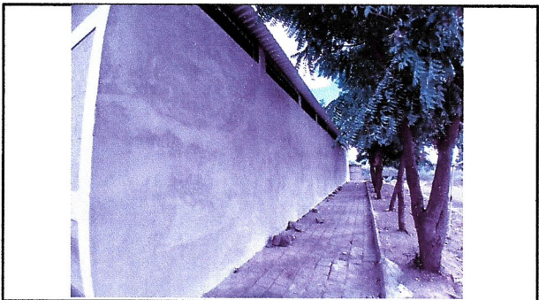
Foto 8: CERNIDO EN MURO FINALIZADO
