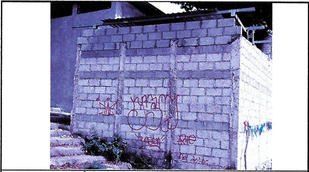
Foto7: REPARACIÓN DE MURO PERIMETRAL DE BLOCK
