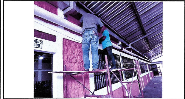
Foto 3: REPARACIÓN DE CANAL Y BAJADA DE AGUA PLUVIAL, TUBO DE PVC 6"
