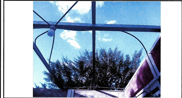
Foto1: TECHO DE LÁMINA DESMONTADO
