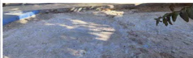
Foto 6: Sustitución de piso de concreto
