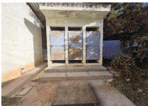
Foto 3: Mantenimiento de puertas y pintura
