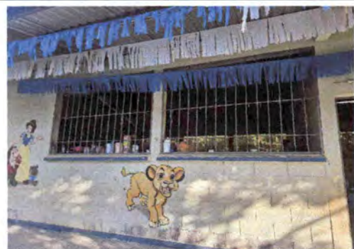
Foto 5: Mantenimiento de balcones
