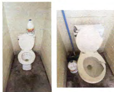
Foto 2: Sustitución e instalación de sanitarios y sus accesorios
