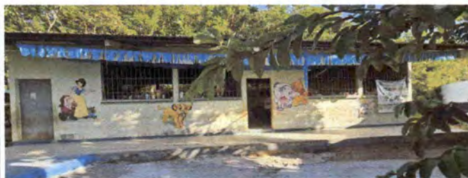
Foto 4: Mantenimiento de pintura en interior y exterior de aulas
