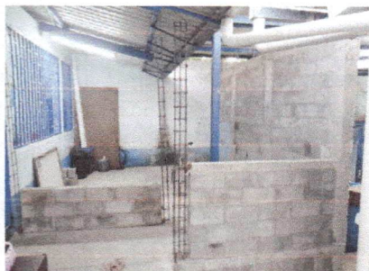
Foto 7: MURO DE PERIMETRAL (AULA)
