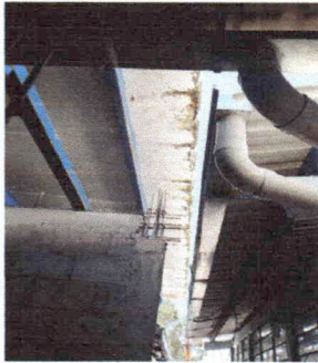
Foto 1: ESTRUCTURA DE TECHO/CUBIERTA DE LÁMINA
