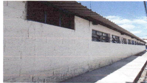
Foto 4: PINTURA EN MUROS DEL PASILLO
