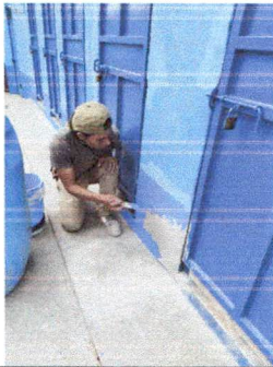
Foto1: INSTALACION DE PUERTAS NUEVAS
