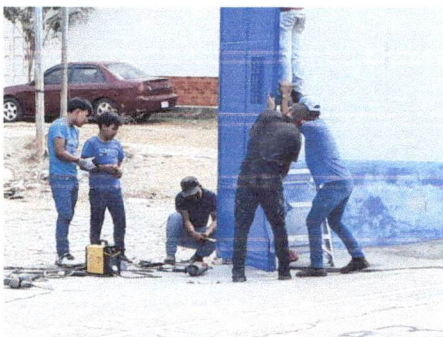
Foto 3: INSTALACION DE PORTON PRINCIPAL
