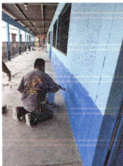
Foto 5: APLICACIÓN DE PINTURA NUEVA EN PAREDES
