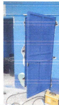
Foto 2: PUERTA DE METAL INSTALADA
