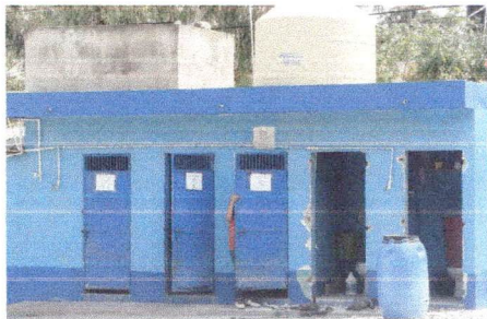
Foto1: REMOVIENDO PUERTAS EN MAL ESTADO
