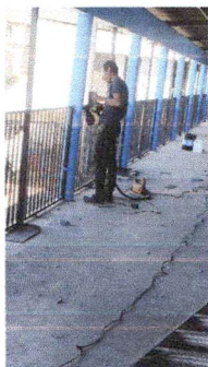
Foto 3: REPARACION Y PINTADO DE BARANDAS
