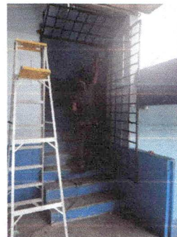
Foto 2: REPARACION DE PUERTA INGRESO 2DO NIVEL
