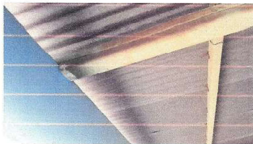
Foto 6: TECHO SIN ANCLAJES Y REFUERZOS
