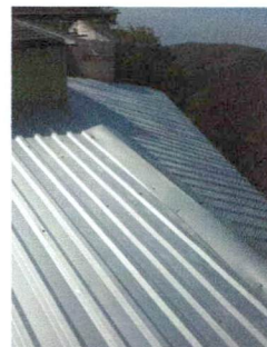
Foto 4: 1.1 Sustitucion de cubierta por lamina troquelada aluzinc calibre 26
