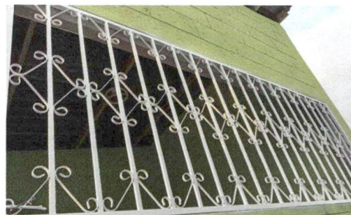
Foto 6: 5.2 Mantenimiento de balcon de metal
