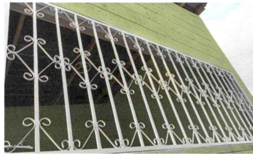
Foto 6: 5.2 Mantenimiento de balcon de metal
