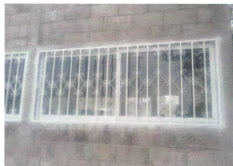
Foto 2: 5.1 Sustitucion tipo ventana tipo persiana por ventanas de PVC y vidrio
