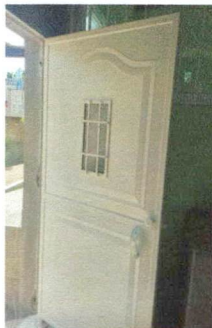
Foto 5: 4.1 Sustitucion de puerta de metal
