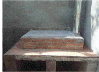
Foto 2: 20-1 Sustitucion de cocina rural incluye chimenea y plancha de metal
