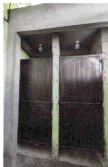
Foto1: 1. 4.1 Sustitucion de puerta de baño
