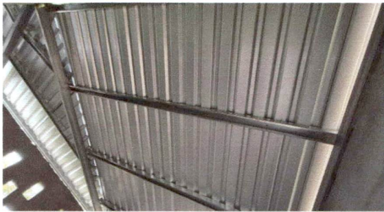
Foto 3: 2.1 sustitucion de estructura de madera por estructura de metal
