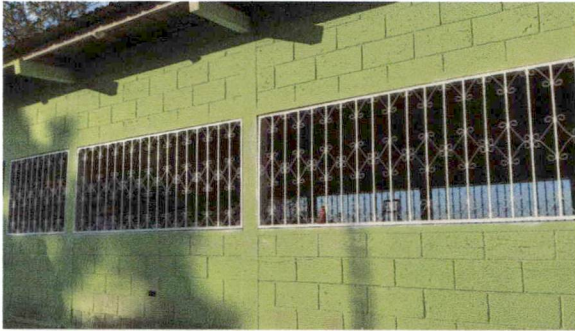
Foto1: 5.2 Mantenimiento de balcones de metal.
