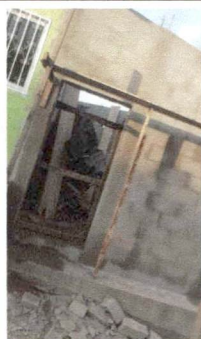
Foto 3: 15.1 Reparacion de muro perimetral.
