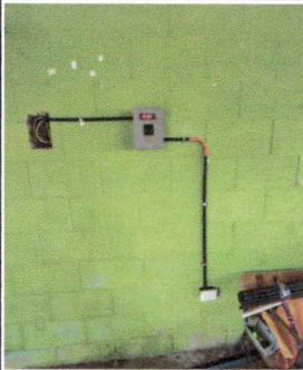
Foto 3: Reparación sistema eléctrico.
