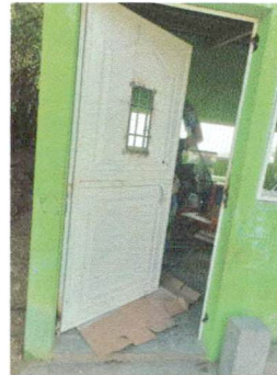
Foto 4: Sustitución de puertas de metal.
