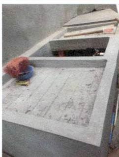
Foto 5: 20.2 Sustitucion de pila.
