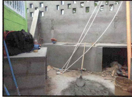
Foto 2: 20.2 Sustitución de pila de cemento de 2 lavadores
