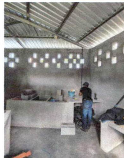
Foto 6: 2.1 Sustitucion de estructura de madera por estructura de metal.
