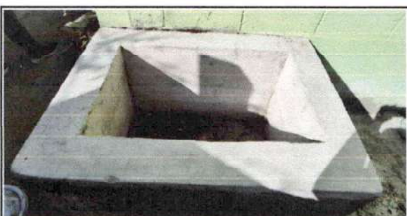
Sustitución de Pila
