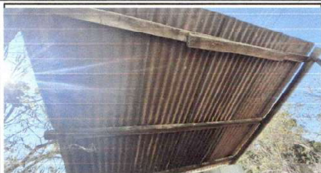
Sustitucion de cubierta de lamina
