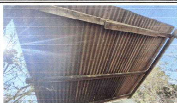
Sustitución de estructura de madera por estructura de metal
