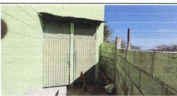
Sistitución de puertas de baños
