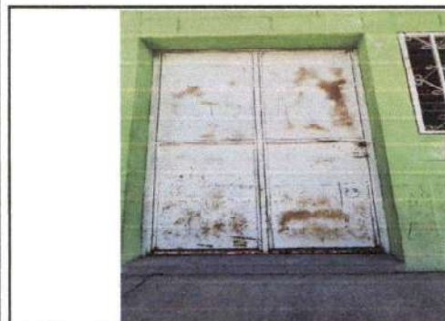
Sustitución de puertas de metal
