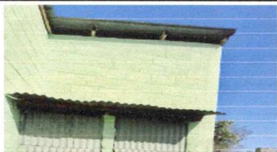
Sustitución de Tinaco
