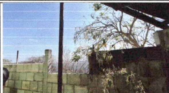
Reparación de muro perimetral
