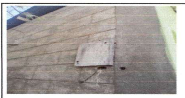
Sustitucion de tablero de filipones
