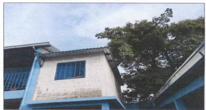
Foto 4: FINALIZACIÓN DE COLOCACIÓN DE TECHO DE DIRECCIÓN
