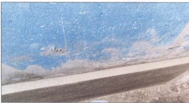
Foto 3: FINALIZACIÓN DE CORTE DE PARED Y FUNDICIÓN EN AULAS
