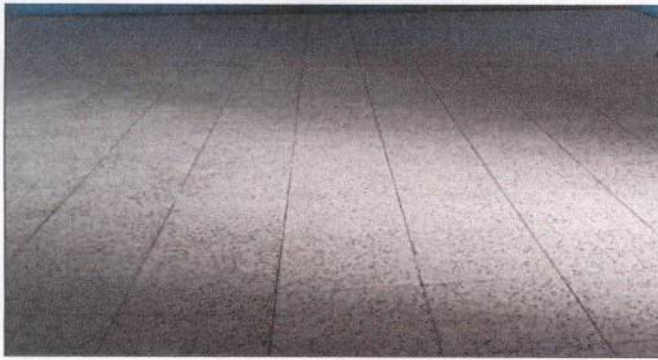
Foto1: FINALIZACIÓN DE COLOCACIÓN DE PISO EN AULAS
