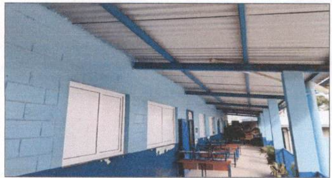
Foto 2: FINALIZACIÓN DE COLOCACIÓN DE VENTANAS EN AULAS
