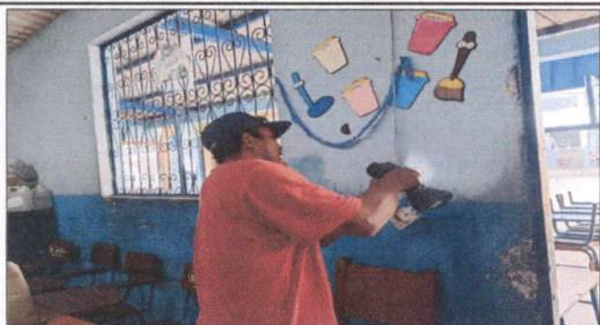
Foto 5: EN PROCESO DE SUSTITUCIÓN DE TOMA CORRIENTE
