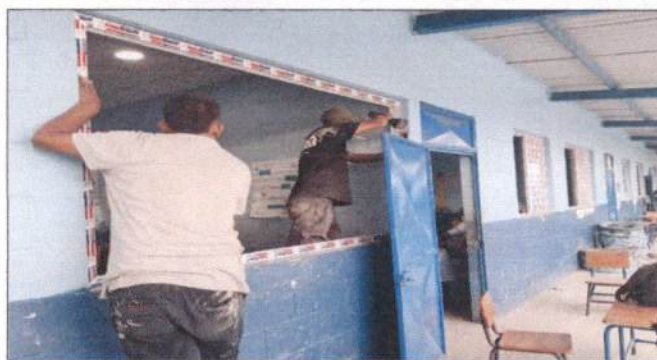
Foto 2: EN PROCESO DE COLOCACIÓN DE VENTANAS EN AULAS
