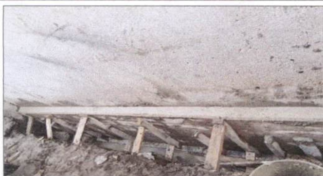
Foto 3: EN PROCESO DE CORTE DE PARED Y FUNDICIÓN EN AULAS
