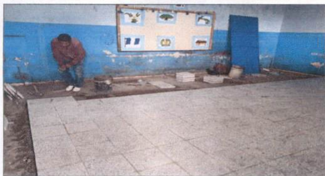
Foto 1: EN PROCESO DE COLOCACIÓN DE PISO EN AULAS
