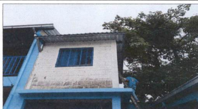
Foto 4: EN PROCESO DE COLOCACIÓN DE TECHO DE DIRECCIÓN
