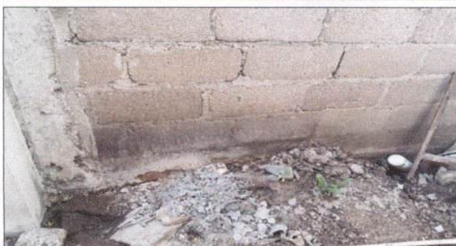
Foto 3: CORTE DE PARED Y FUNDICIÓN EN AULAS
