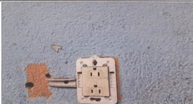
Foto 5: SUSTITUCIÓN DE TOMA CORRIENTE
