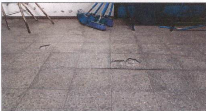
Foto 1: REPARACIÓN DE PISO EN AULAS
