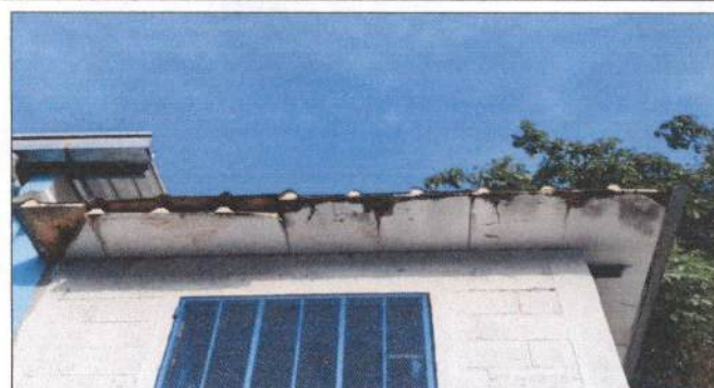
Foto 4: REPARACIÓN DE TECHO DE DIRECCIÓN
