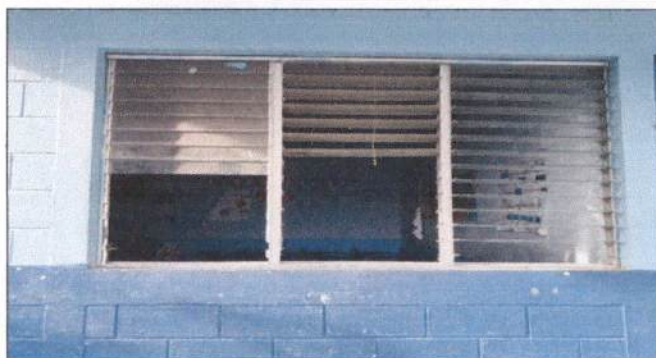
Foto 2: REPARACIÓN DE VENTANAS EN AULAS
