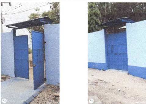
Foto 3: MANO DE OBRA ESPECIALIZADA (ALBAÑILERÍA, HERRERÍA, ELECTRICIDAD Y PLOMERÍA). FABRICACIÓN E INSTALACIÓN DE PORTÓN DE METAL DE INGRESO
