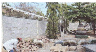
Foto1: PISO TORTA DE CONCRETO. REPARACIÓN DE PISO DE TORTA DE CONCRETO CON MANO DE OBRA Y MATERIAL INCLUIDO.
