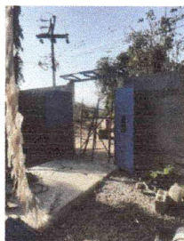
Foto 3: MANO DE OBRA ESPECIALIZADA (ALBAÑILERIA, HERRERIA, ELECTRICIDAD Y PLOMERÍA). FABRICACIÓN E INSTALACIÓN DE PORTÓN DE METAL DE INGRESO
