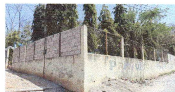
Foto 2: MURO PERIMETRAL. REPARACIÓN DE MURO PERIMETRAL DE BLOCK, CON SOLERAS INTERMEDIAS Y COLUMNAS.
