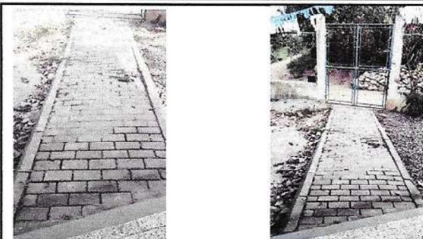
Foto 1: PISO TORTA DE CONCRETO. REPARACIÓN DE PISO DE TORTA DE CONCRETO CON MANO DE OBRA Y MATERIAL INCLUIDO.
