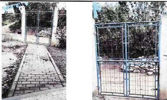
Foto 3: MANO DE OBRA ESPECIALIZADA (ALBAÑILERÍA, HERRERÍA, ELECTRICIDAD Y PLOMERÍA). FABRICACIÓN E INSTALACIÓN DE PORTÓN DE METAL DE INGRESO
