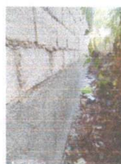
Foto 6: repello de 15 metros en el muro perimetral
