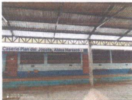
Foto1: Cambio de lámina en mal estado
