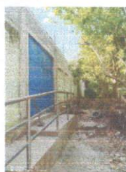
Foto 4: reparacion de muro perimetral
