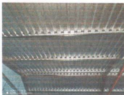
Foto 2: Cambio de estructura del techo en mal estado
