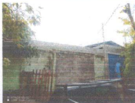
Foto 3: reparación de muro perimetral
