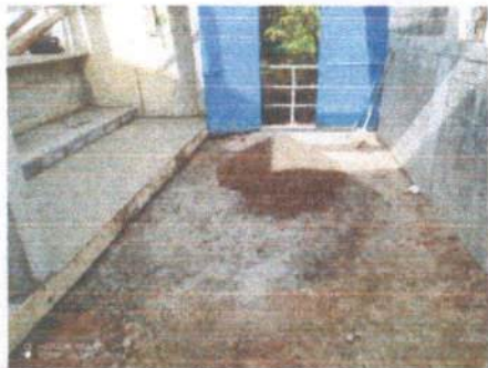
Foto1: Piso. Reparación de torta de concreto
