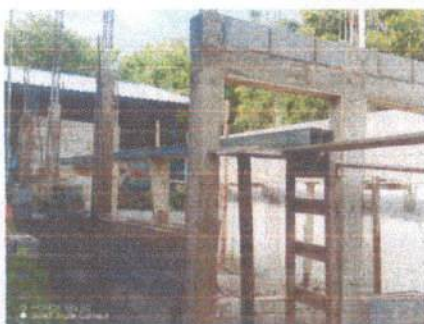
Foto 5: seguimiento de muro existente de block
