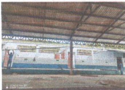
Foto 1: cambio de lámina en mal estado
