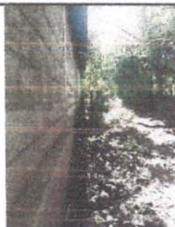
REPEIIO DE 16 METROS EN EL MURO PERIMETRAL
