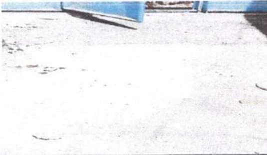
REPARACION DE TORTA DE CONCRETO
