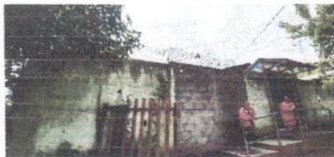
REPARACION DE MURO PERIMETRAL
