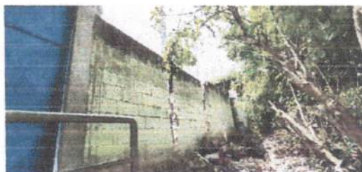
REPARACION DE MURO PERIMETRAL
