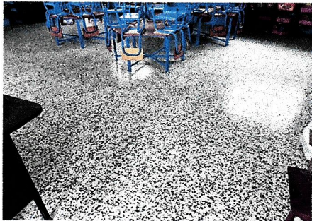
Foto 5: PISO. Sustitución de piso de concreto por piso de granito AULA 7
