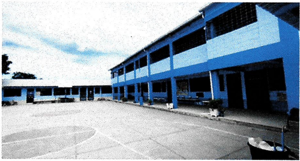
Foto 2: PINTURA EN MUROS EXTERIORES E INTERIORES PASILLO.
