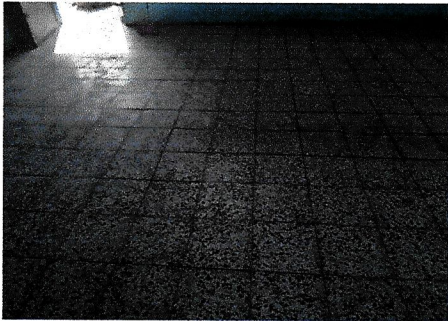
Foto 2: PISO. Sustitución de piso de concreto por pisos de granito en AULA 2
