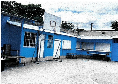
Foto 6: CUBIERTA DE LÁMINA Y ESTRUCTURA DE TECHO. SUSTITUCIÓN DE LÁMINA POR LÁMINA TROQUELADA ALUZINC CALIBRE 26
