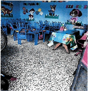
Foto1: PISO, Sustitución de piso de concreto por piso de granito en AULA 1
