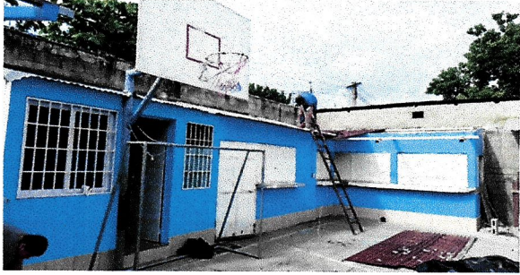
Foto 6: CUBIERTA DE LÁMINA Y ESTRUCTURA DE TECHO. SUSTITUCIÓN DE LÁMINA POR LÁMINA TROQUELADA ALUZINC CALIBRE 26
