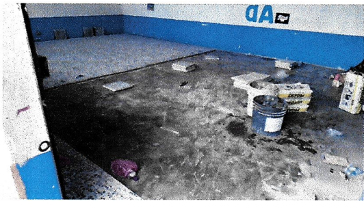
Foto 2: PISO. Sustitución de piso de concreto por pisos de granito en AULA 2
