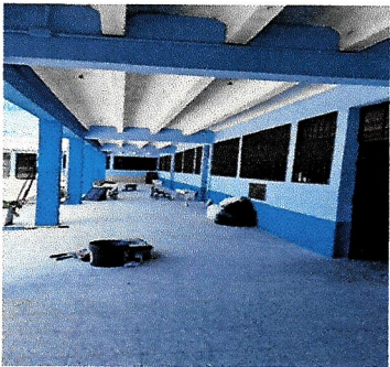
Foto 3 PINTURA EN MUROS EXTERIORES E INTERIORES PASILLO.
