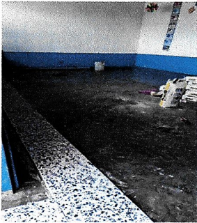
Foto 3 PISO. Sustitución de piso de concreto por piso de granito AULA 5
