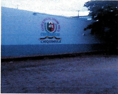
Foto 2: PINTURA EN MUROS EXTERIORES E INTERIORES PASILLO.
