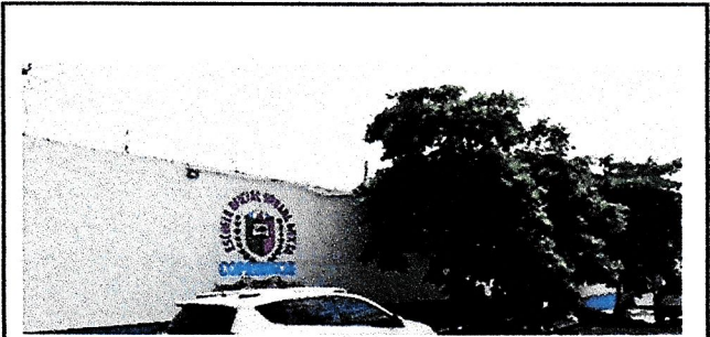
Foto1: PINTURA EN MURO EXTERIORES E INTERIORES PASILLOS.
