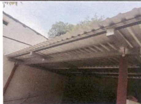
Foto 10.1: Sustrución de lamina, por lamina troquelada aluzinc calibre 26
