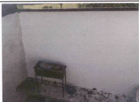
Foto 5: Repello en muro
