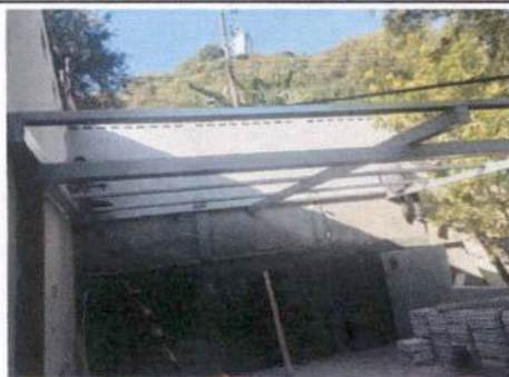
Foto 10: Sustrución de estructura de madera, por metal
