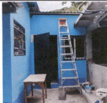
Foto 2: Sustrucción e instalación de puerta metálica
