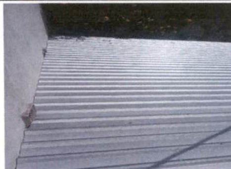
Foto 4: Sustrucción de lámina, por lamina troquelada aluzinc calibre 26
