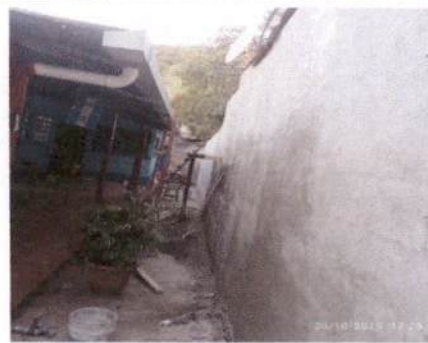
Foto 9: Repello de muro
