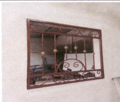
Foto 8.1: Sustrución e instalación de balcon metalico
