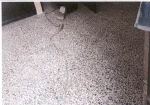
Foto 1: Sustrucción de piso de granito
