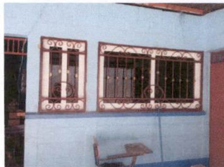
Foto 8: Sustrución e instalación de ventanas de PVC corrediza
