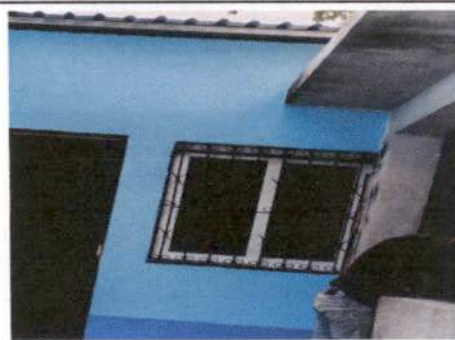
Foto 6: Sustrucción a balcon de metal
