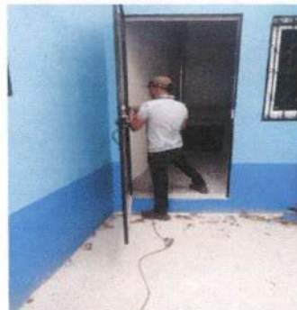
Foto 2: Sustitución e instalación de puerta metálica
