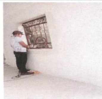
Foto 6: Sustitución a balcon de metal
