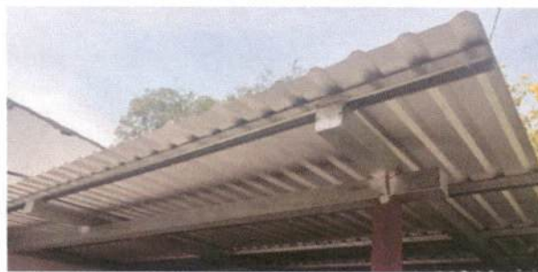
Foto 10.1: Sustrución de lamina, por lamina troquelada aluzinc calibre 26
