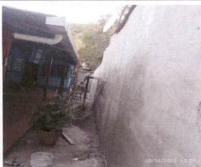
Foto 5: Repello en muro
