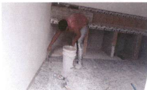
Foto1: Sustitución de piso de granito
