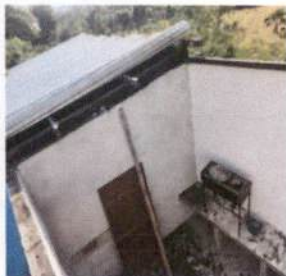
Foto7: Sustrución de estufa rural(completa) incluyendo chimenea y plancha de metal
