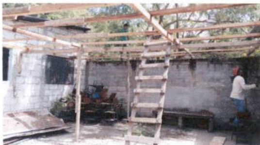
Foto 8.1: Sustrución e instalación de balcon metalico
