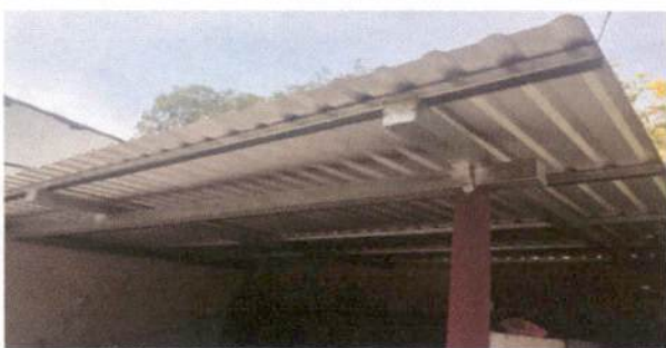
Foto 10: Sustrución de estructura de madera, por metal
