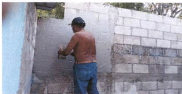
Foto 9: Repello de muro
