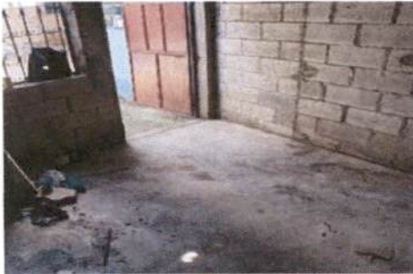
Foto 1: Sustitución de piso de granito
