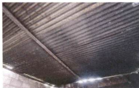
Foto 4: Sustitución de lámina, por lamina troquelada aluzinc calibre 26
