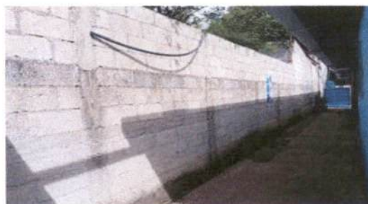
Foto 9: Repello de muro
