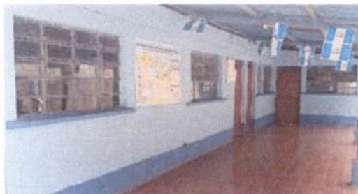
Foto 8: Sustitución e instalación de ventanas de PVC corrediza
