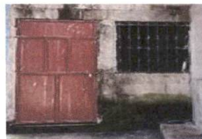
Foto 6: Sustitución a balcon de metal
