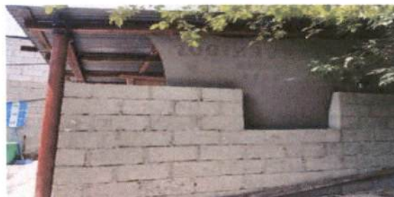
Foto 10.1:Sustitución de lamina, por lamina troquelada aluzinc calibre 26
