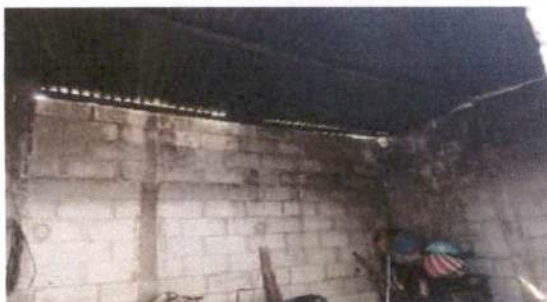
Foto 5: Repello en muro
