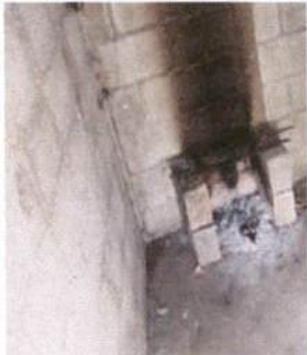
Foto7: Sustitución de estufa rural(completa) incluyendo chimenea y plancha de metal
