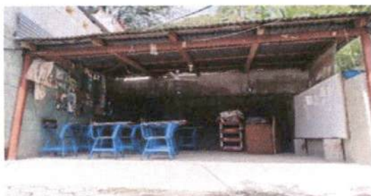
Foto 10: Sustitución de estructura de madera, por metal
