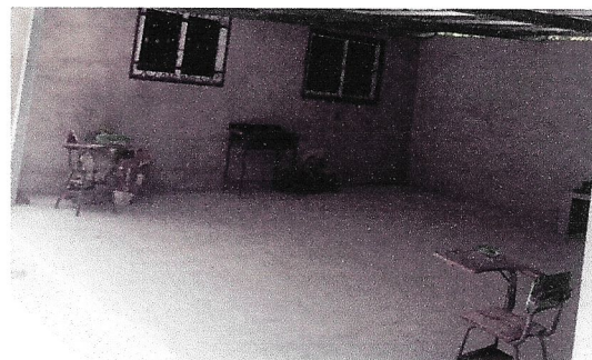
Foto 7: Repello en muro
