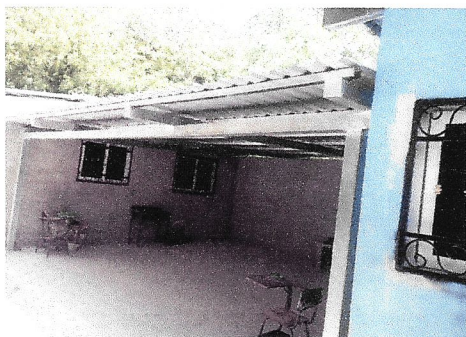
Foto 6: Sustrucción de lamina, por lamina troquelada aluzinc calibre 26
