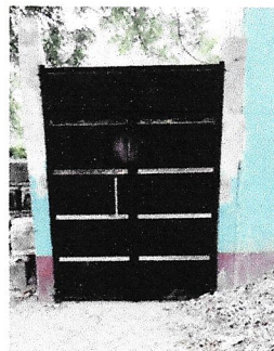
Foto 9: Sustrucción e instalación de portón de metal
