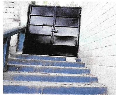
Foto 9: Sustitución e instalación de portón de metal
