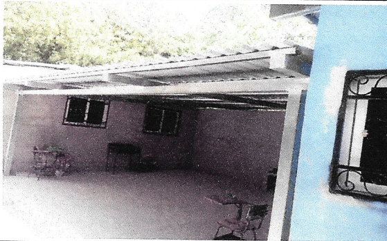
Foto 8: Sustitución de piso de torta de concreto
