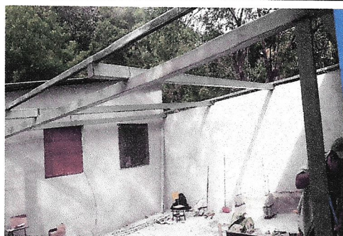
Foto 5: Sustitución de estructura de soporte de madera por metal
