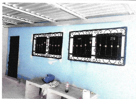
Foto 2: Sustitución e instalación de ventana de PVC corrediza
