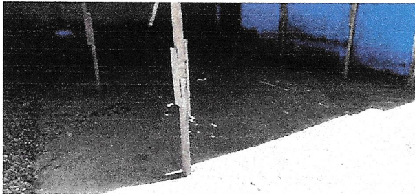
Foto 8: Sustrucción de piso de torta de concreto
