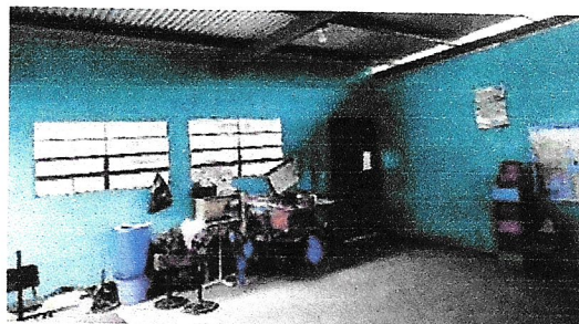
Foto 2: Sustrucción e instalación de ventana de PVC corrediza
