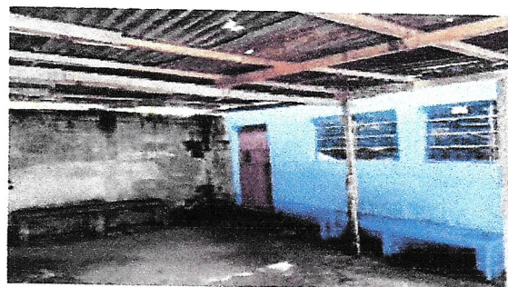
Foto 5: Sustrucción de estructura de soporte de madera por metal
