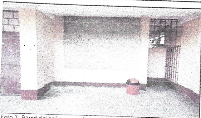
Foto 3: Pared del baño reparada pendiente de pintura
