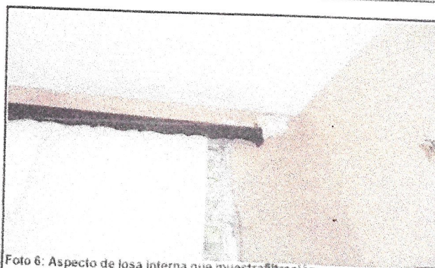
Foto 6: Aspecto de losa interna que muestra infiltración
