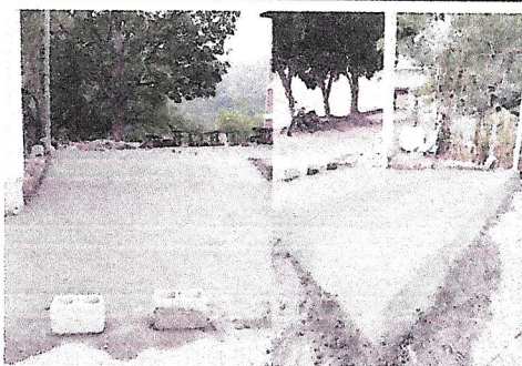
Foto 10: REPARACION DE CUNETETA DE CONCRETO EN ENTRADA PRINCIPAL
