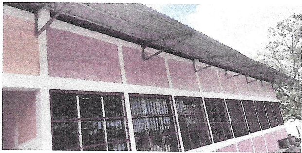
Foto 2: SEGUIMIENTO DE ESTRUCTURA METALICA EN LA PARTE DE ATRÁS DE AULAS
