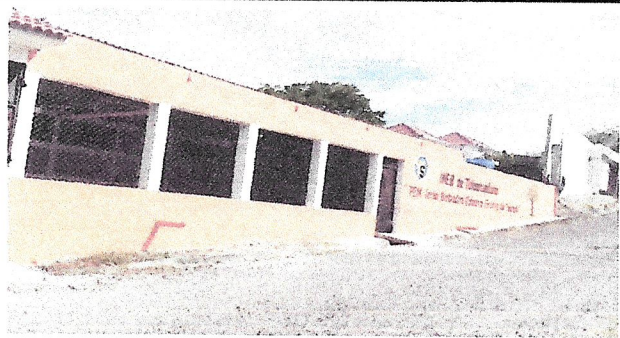
Foto 13: PINTURA EN MURO EXTERIOR DE INSTITUTO
