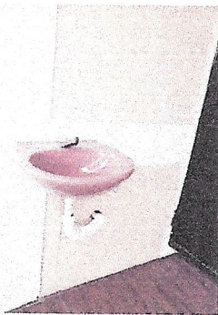
Foto 14: SUSTITUCION DE LAVAMANOS
