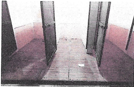
Foto 15: SUSTITUCION DE INODOROS
