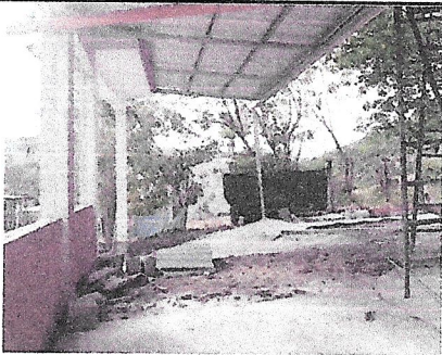
Foto 4: SEGUIMIENTO CUBIERTA DE LAMINA PATIO DE AULAS
