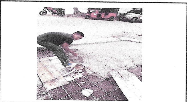
Foto 10: REPARACION DE CUNETTA DE CONCRETO EN ENTRADA PRINCIPAL
