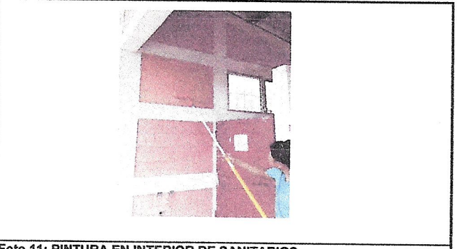
Foto 11: PINTURA EN INTERIOR DE SANITARIOS
