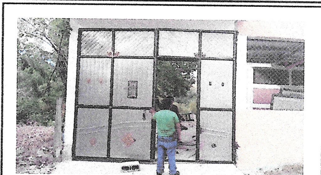
Foto 8: FABRICACION E INSTALACION DE PORTON DE METAL EN ENTRADA PRINCIPAL
