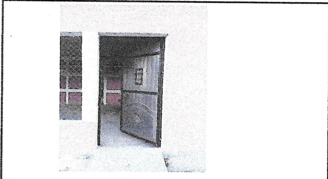
Foto 7: FABRICACION E INSTALACION DE PUERTA DE METAL EN ENTRADA PRINCIPAL
