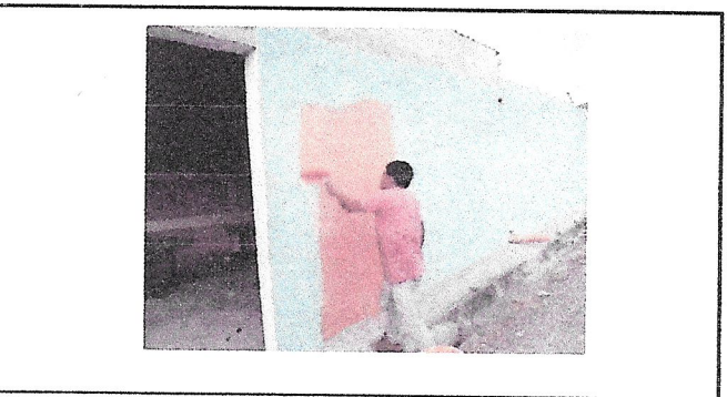
Foto 13: PINTURA EN MURO EXTERIOR DE INSTITUTO
