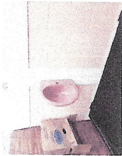
Foto 14: SUSTITUCION DE LAVAMANOS
