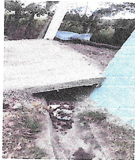
Foto 10: REPARACION DE CUNETA DE CONCRETO EN ENTRADA PRINCIPAL
