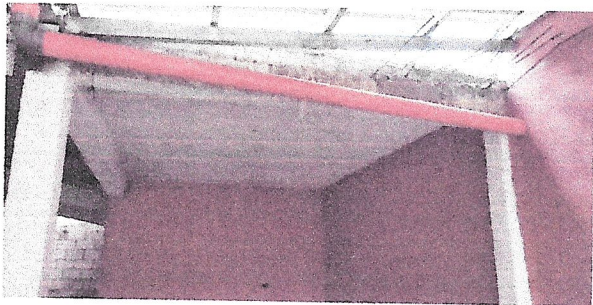
Foto 9: REPARACION DE BAJADA DE AGUA Y SEGUIENTO DE CANAL
