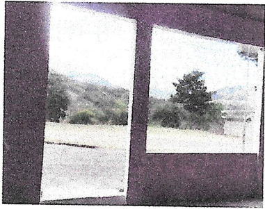
Foto 7: FABRICACION E INSTALACION DE PUERTA DE METAL EN ENTRADA PRINCIPAL
