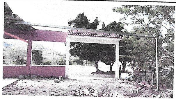
Foto 4: SEGUIMIENTO CUBIERTA DE LAMINA PATIO DE AULAS
