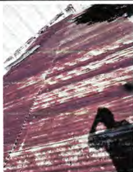
Foto 1: CUBIERTA DE LÁMINA. SUSTITUCIÓN DE LÁMINA POR LÁMINA ACANALADA ALUZINC CALIBRE 26, INSTALADA CON SU CAPOTE (INCLUYE DESMONTAJE DE LÁMINA EN MAL ESTADO E INSTALACIÓN DE LÁMINA UBICADA EN TECHO DEL GIMNASIO LADO DERECHO DEL ESTABLECIMIENTO EDUCATIVO EODP JORNADA VESPERTINA, 90 M2 DE LÁMINA).
