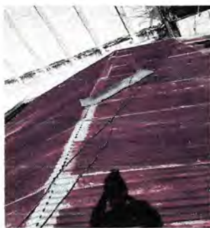
Foto 3: PINTURA EN LÁMINA Y MURO EXTERIOR DEL PASILLO. MANO DE OBRA POR APLICACIÓN DE PINTURA EN LÁMINA UBICADA EN TECHO DEL GIMNASIO LADO IZQUIERDO DEL ESTABLECIMIENTO EDUCATIVO EODP JORNADA VESPERTINA, 90 M2 DE LÁMINA (INCLUYE LIJADO Y PINTADO).
