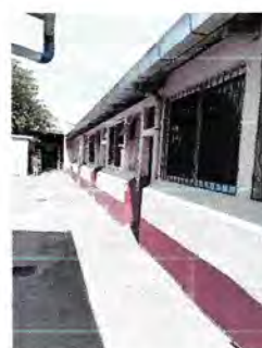
Foto 4: PINTURA EN LÁMINA Y MURO EXTERIOR DEL PASILLO. MANO DE OBRA ESPECIALIZADA (RESANE, ESCREPEO Y APLICACIÓN DE PINTURA EN CORREDOR UBICADO EN LADO DERECHO DEL ESTABLECIMIENTO EDUCATIVO EODP JORNADA VESPERTINA).
