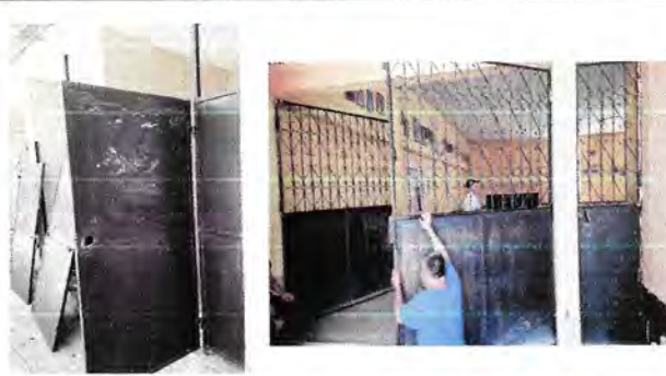
Foto 2: MANTENIMIENTO A PUERTAS Y PORTON. MANTENIMIENTO A PORTON DE METAL DE ENTRADA A LA EODP JORNADA VESPERTINA (LIJADO, REPARADO, CAMBIO DE CHAPA Y PINTADO).
