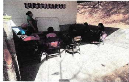
Foto 2: MUROS EXISTENTES EN AULA
