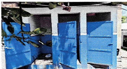
Foto 5: SERVICIOS SANITARIOS Y SUS ACCESORIOS. MANTENIMIENTO A ESTRUCTURA ( LIJADO, CEPILLADO, APLICACIÓN DE PINTURA) A PUERTAS DE SERVICIOS SANITARIOS.
