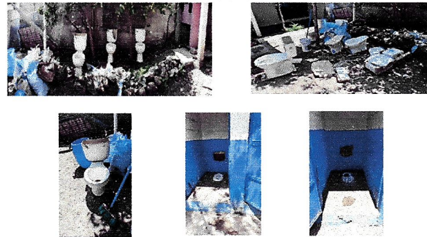
Foto 4: SERVICIOS SANITARIOS Y SUS ACCESORIOS. SUSTITUCIÓN DE INODOROS CON SUS ACCESORIOS.
