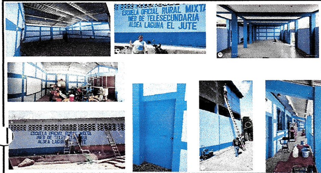
Foto1: PINTURA EN MUROS EXTERIORES E INTERIORES. MANO DE OBRA POR APLICACIÓN DE PINTURA EN MUROS EXTERIORES E INTERIORES DE AULAS Y DEL SALÓN DE USOS MÚLTIPLES, BARANDAS Y BALCONES DEL ESTABLECIMIENTO EDUCATIVO (DEL SEGUNDO NIVEL).
