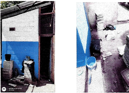
Foto 3: MANO DE OBRA ESPECIALIZADA. FABRICACIÓN E INSTALACIÓN DE PUERTA DE METAL.
