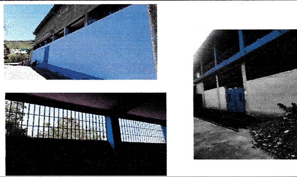
Foto 2: MANO DE OBRA ESPECIALIZADA. ELABORACIÓN DE BALCONES DE ESTRUCTURA METÁLICA CON TELA MALLA.
