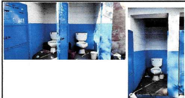
Foto 4: SERVICIOS SANITARIOS Y SUS ACCESORIOS. SUSTITUCIÓN DE INODOROS CON SUS ACCESORIOS.
