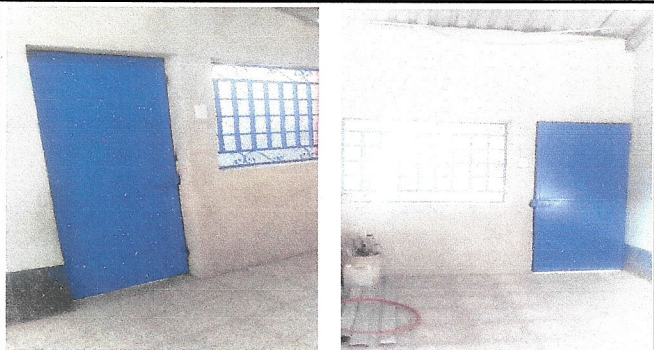
Foto 2: Colocada puerta y balcón
