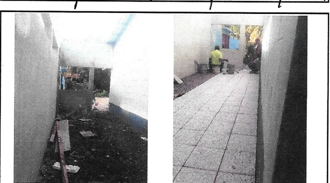
Foto 4: Colocación del piso en aula
