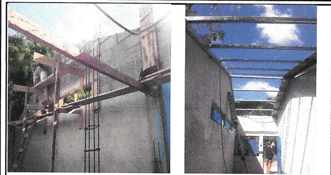
Foto1: Colocación del techo
