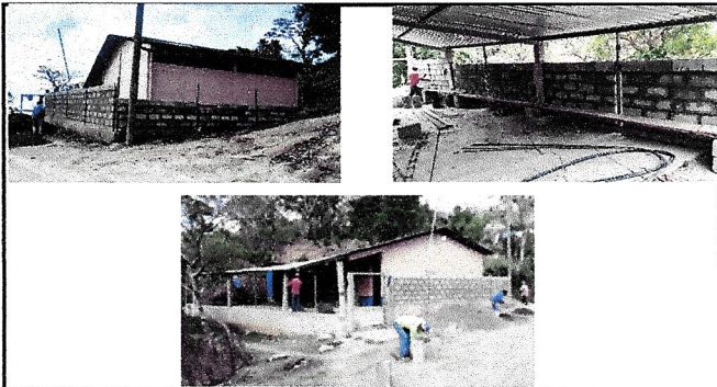
Foto 3: MURO PERIMETRAL. REPARACIÓN DE MURO PERIMETRAL DE BLOCK, CON SOLERAS INTERMEDIAS Y COLUMNAS.
