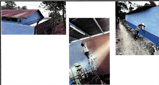
Foto1: PINTURA EN MUROS EXTERIORES E INTERIORES. APLICACIÓN DE PINTURA EN MURO PERIMETRAL EXTERIOR, EXTERIOR E INTERIOR DEL AULA DEL ESTABLECIMIENTO EDUCATIVO.
