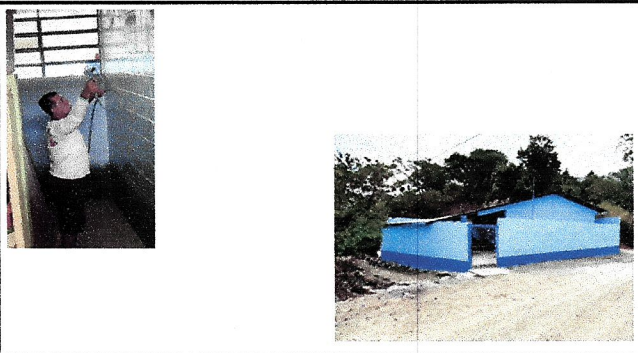
Foto 2: PINTURA EN MUROS EXTERIORES E INTERIORES. APLICACIÓN DE PINTURA EN MURO PERIMETRAL EXTERIOR, EXTERIOR E INTERIOR DEL AULA DEL ESTABLECIMIENTO EDUCATIVO.
