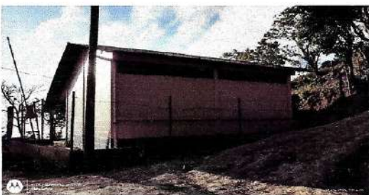
Foto 3: MURO PERIMETRAL. REPARACIÓN DE MURO PERIMETRAL DE BLOCK, CON SOLERAS INTERMEDIAS Y COLUMNAS.
