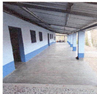
Foto 2: ESTRUCTURA DE TECHO. SUSTITUCIÓN DE ESTRUCTURA DE SOPORTE DE MADERA, POR METAL (DESMONTAJE Y MONTAJE).
