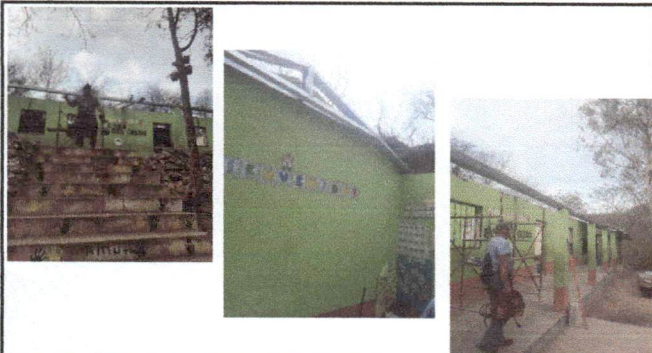
Foto 1: CUBIERTA DE LÁMINA. SUSTITUCIÓN DE LÁMINA, POR LÁMINA TROQUELADA ALUZINC CALIBRE 26; (DESMONTAJE Y MONTAJE).
